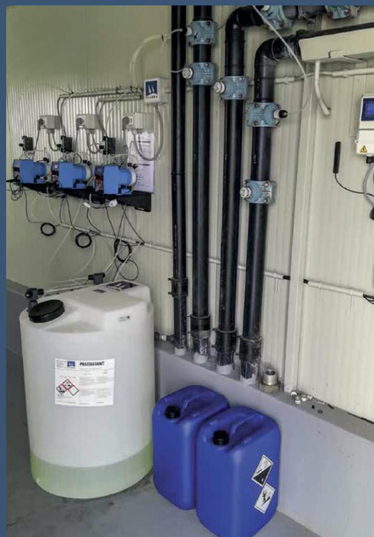
*Impianto di dosaggio biossido di cloro stabilizzato con attivatore e filmante protettivo per acque sanitarie con sistema di comunicazione dati ed errori tramite modulo Ethernet.*
